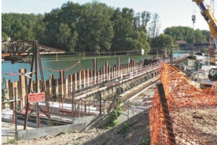
Travaux de création d'une digue de fondation, rive droite, Tillyenay (automne 2009).
