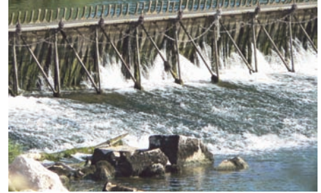
Détail du mécanisme de barrage à aiguilles d'Auxonne depuis l'aval.
