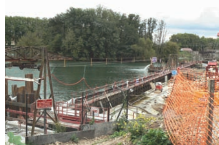
La digue de fondation en béton armé achevée (printemps 2010).
