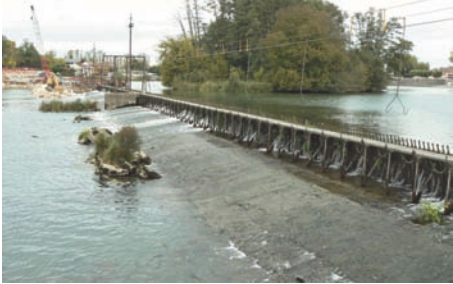
Travaux vus depuis la rive gauche à Auxonne (automne 2009).
