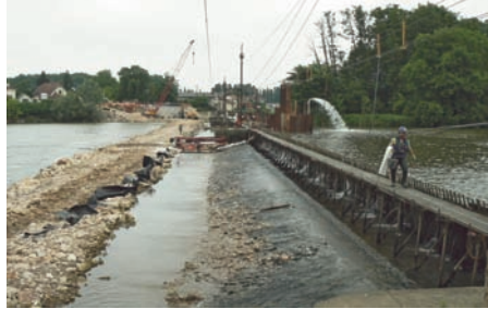
Travaux vus depuis la rive gauche à Auxonne (printemps 2010).
